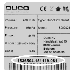
Sticker aan binnenzijde DucoBox
